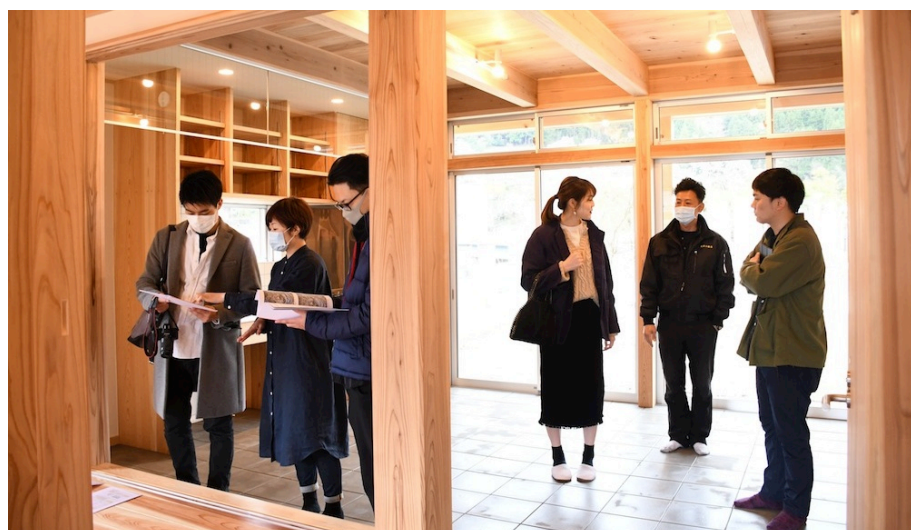
蓄熱効果の高い土間空間。大きな柱は神山町産スギ材の大黒柱
