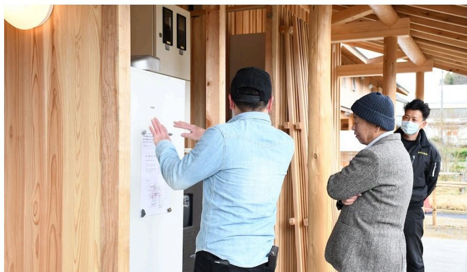
木質バイオマスを利用し、お湯をつくる仕組みを説明する設備屋さん
